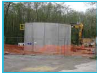
Construction du bassin avant enfoncement dans le sol par havage
