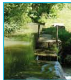
Canal du moulin de Bassilour
